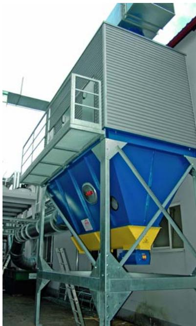
Die Abreinigung der Filteranlage erfolgt über Spülluftventilatoren. Durch die Spülluftreinigung der Filter kann die Abreinigung auch während des Betriebs der Anlage stattfinden.
